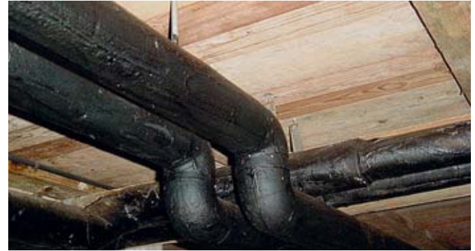
asbesthaltiger Bitumenanstrich
