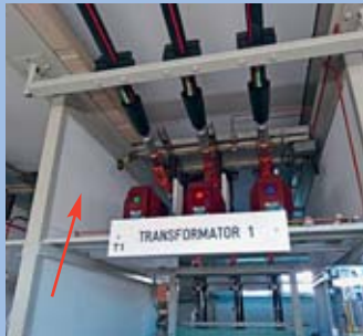
Brandschutzplatten als Trennwand
