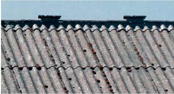
Asbestzementplatten
