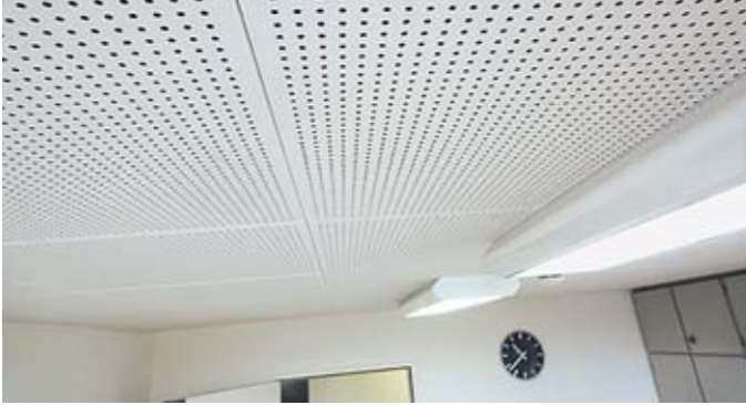
Deckenplatten bei abgehängten Decken
