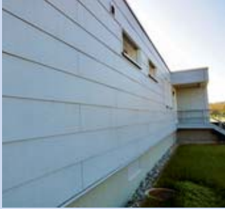
Asbesthaltige Fassadenplatten
