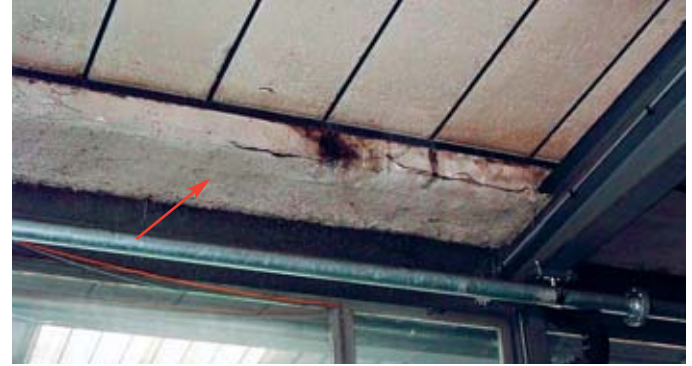
Spritzasbestisolation an Dachkonstruktion
